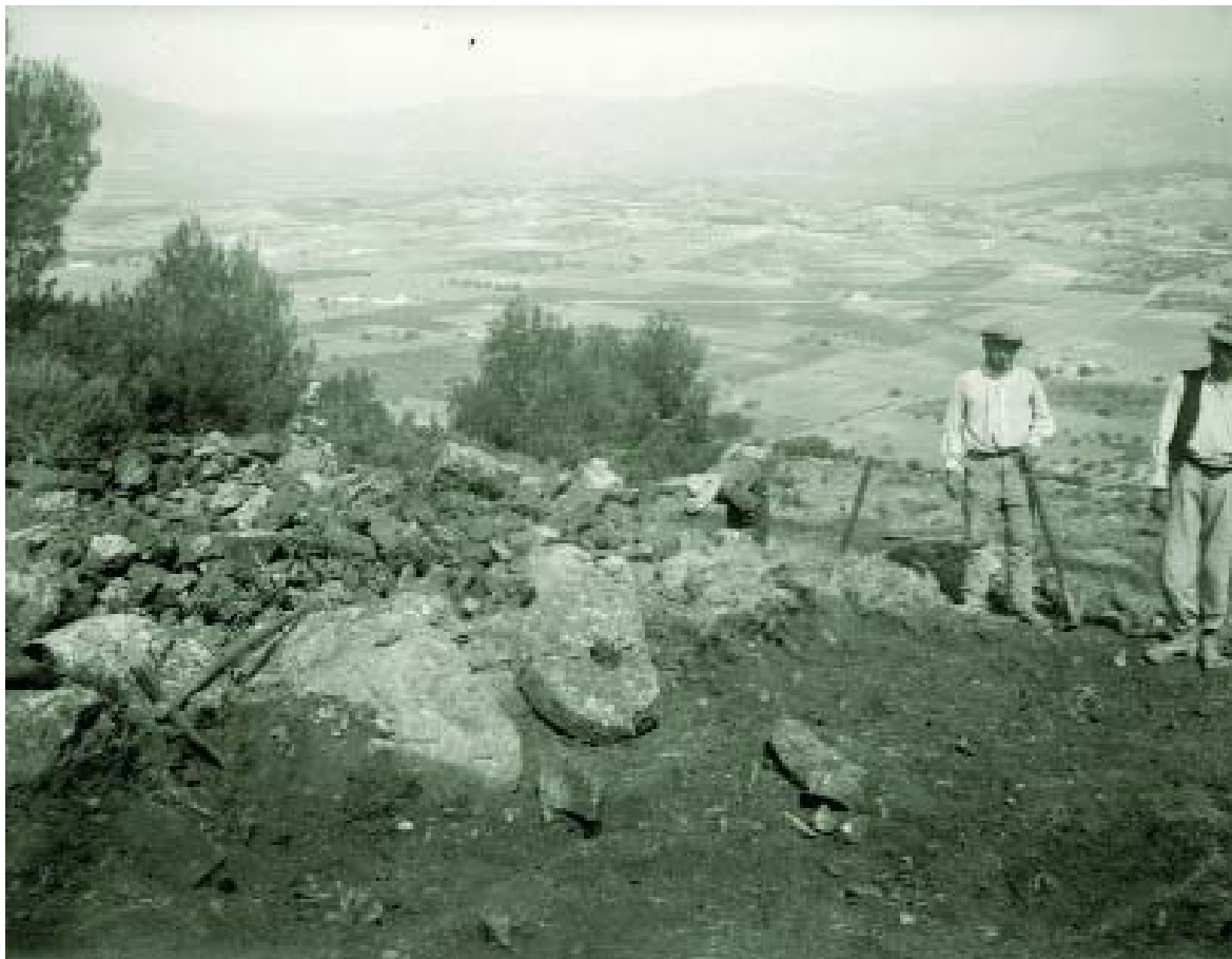
5. Detalle de excavación de la Bastida de les Alcusses (Moixent). Dos obreros posan junto a un gran molino en uno de los departamentos. 1928.
