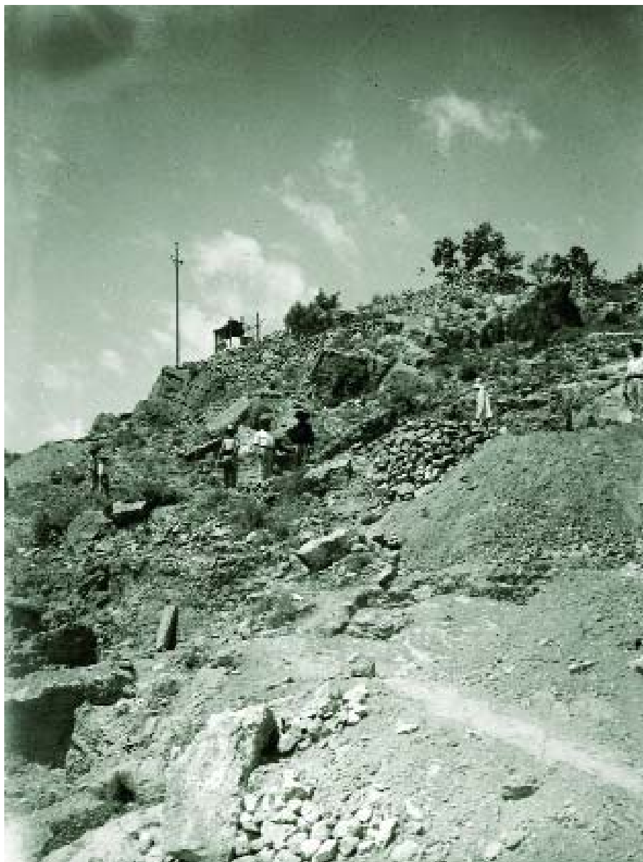
45. Vista general de la excavación en la ladera del Tossal de Sant Miquel (Lliria). Hacia 1936. [Placa de vidrio. SIP 254]
