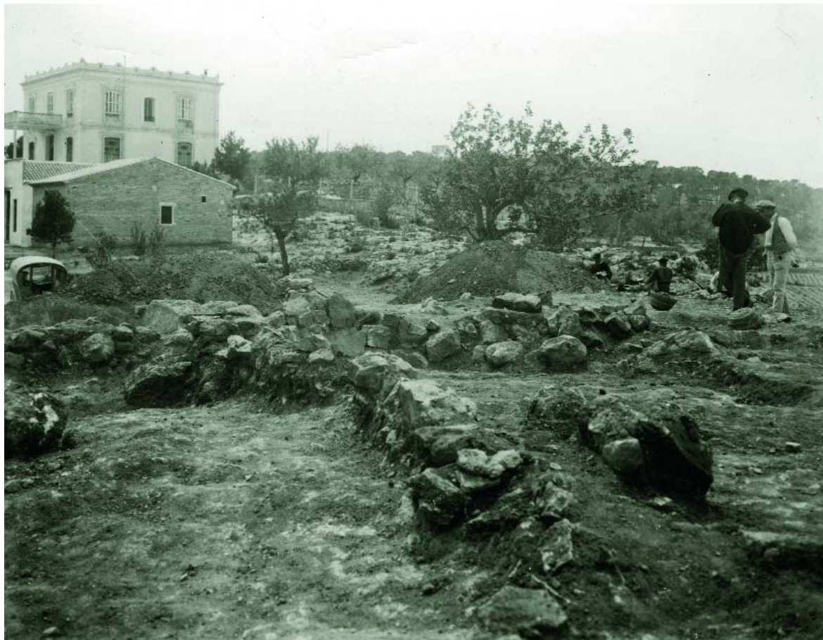
76. Vista de la excavación en la Muntanyeta de Cabrera del Vedat (Torrent). 1931. [Placa de vidrio. SIP 620]
