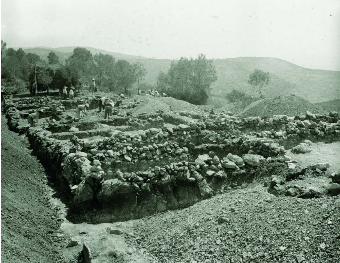
2. Vista general de obreros trabajando en los departamentos de la Bastida de les Alcusses (Moixent). En primer término aparece el dept. 193. 1931.
